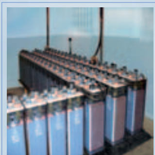
Рис.20 Смонтированная батарея Classic OPzS
