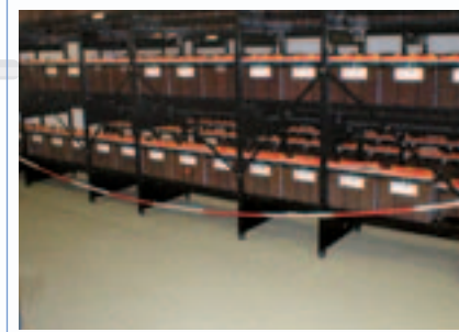
Рис. 23 Смонтированные батареи Classic Energy Bloc
