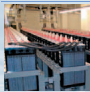
Рис. 17 Смонтированная батарея Classic OCSM
