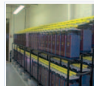
Рис. 24 Смонтированная батарея Classic OGi
